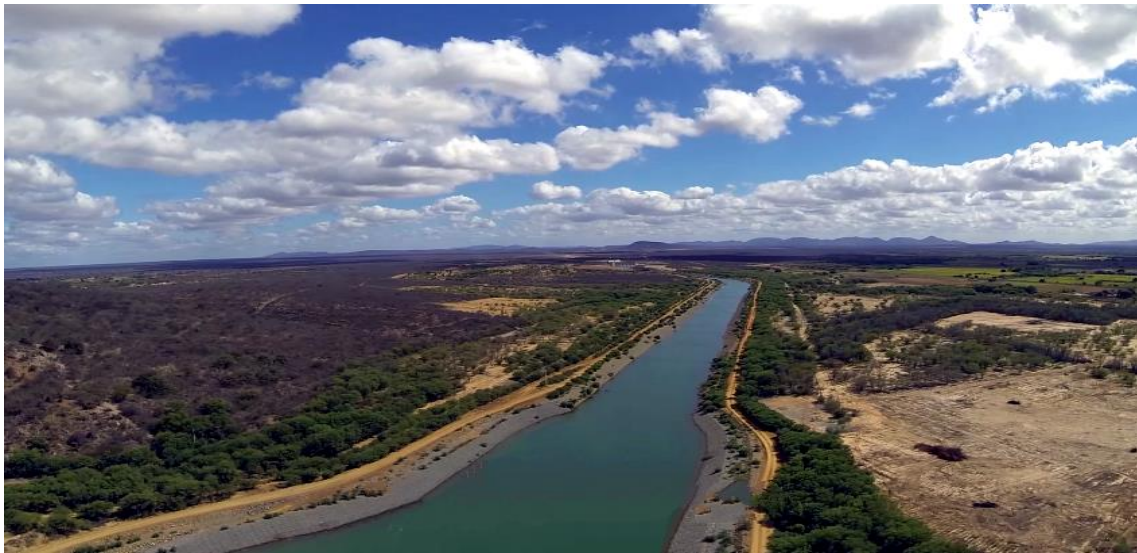
Figura 3: Obras da transposição.
