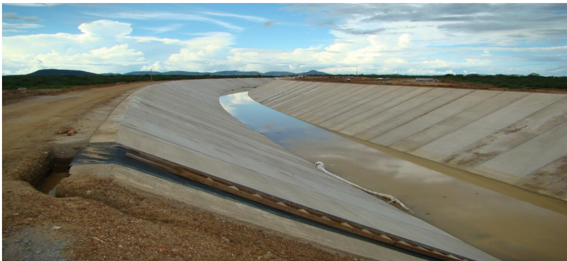
Figura 2: Obras da transposição.
