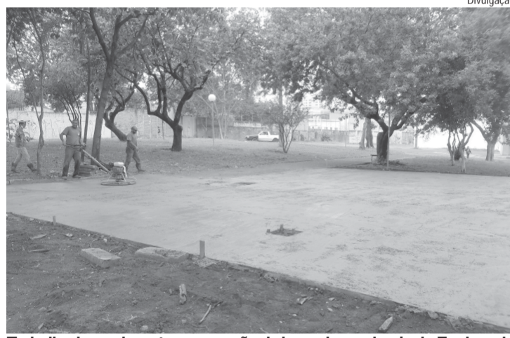
Trabalhadores durante a execução da base da academia do Esplanada
