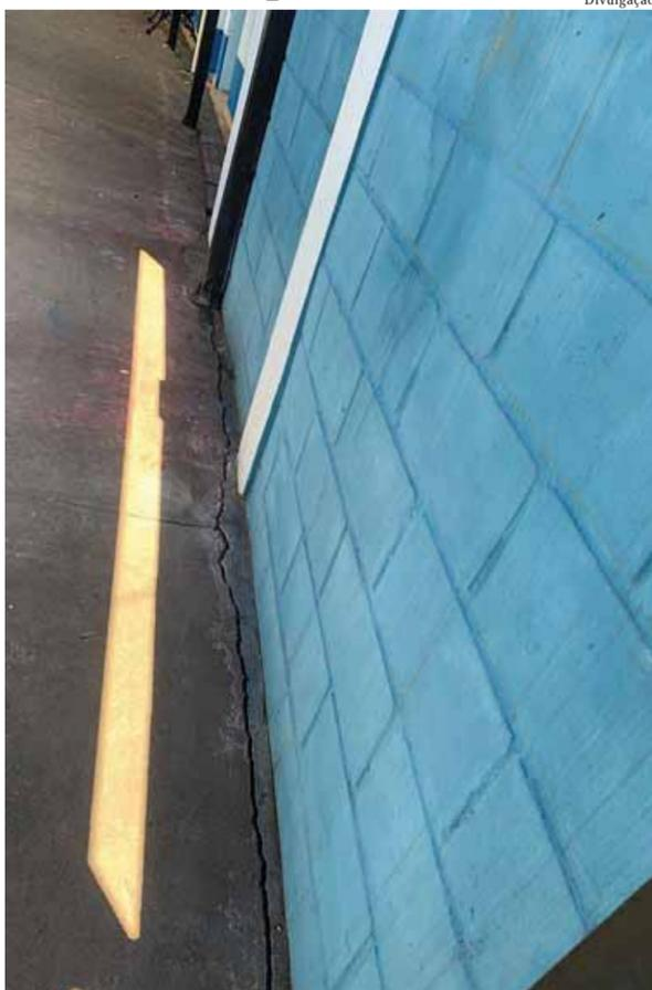
A rachadura indica que pode haver uma erosão e risco de desmoronamento
